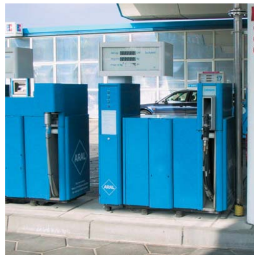
Раздаточные колонки для сжиженного (LNG) и сжатого (CNG) природного газа на одной заправочной станции (LCNG)
